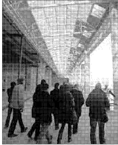
Visita al cantiere Tutto pronto a marzo
