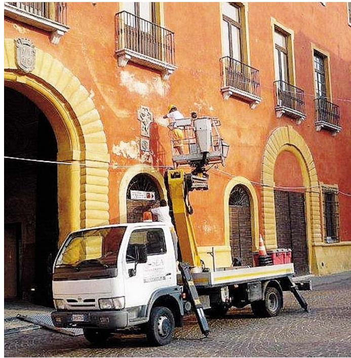
Ieri i tecnici hanno completato l'installazione dei quadri elettrici in via Gonzaga che serviranno agli espositori
